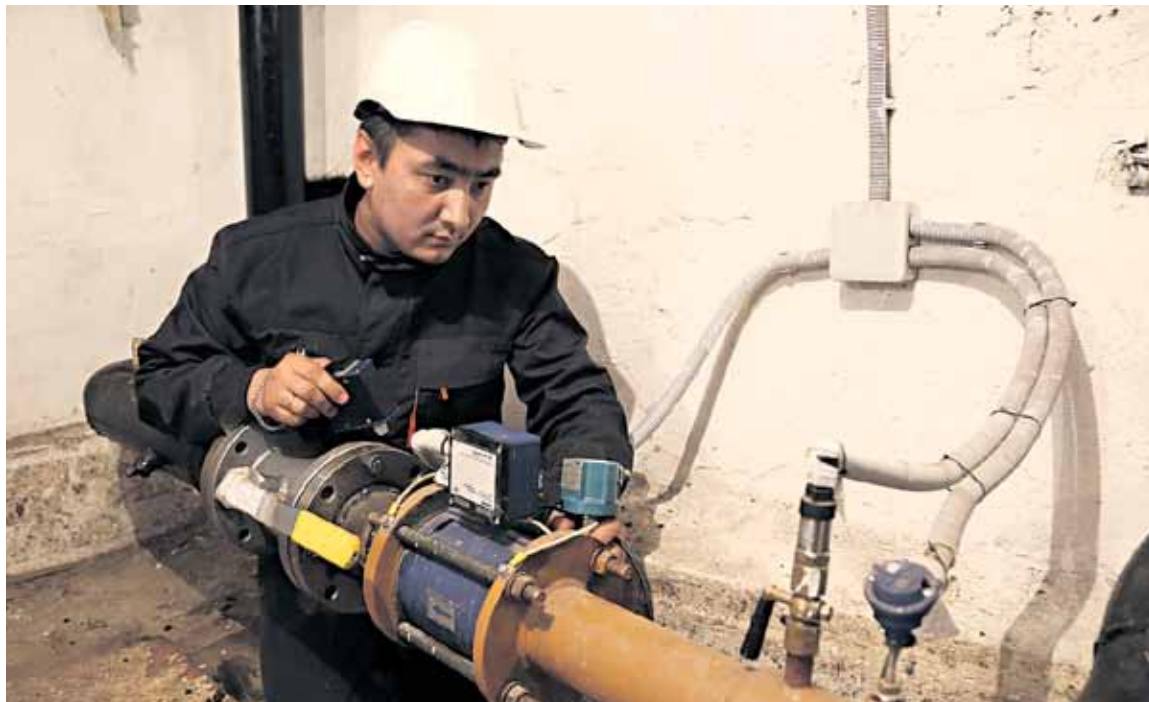
Инженер-наладчик должен проверить каждую деталь - как работает оборудование, нет ли протечек и поврежденных. Фото Александра ФИРСОВА
